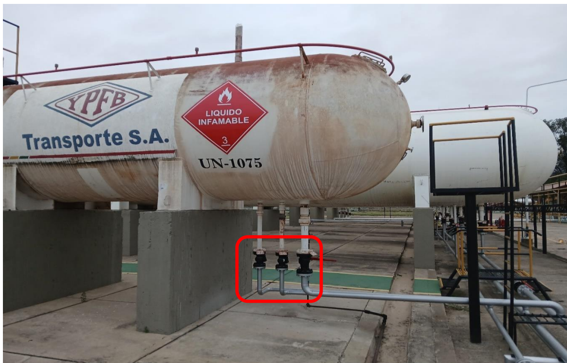
Figura 3: Conexiones a ser desembridadas y desenroscadas del tanque V-09
