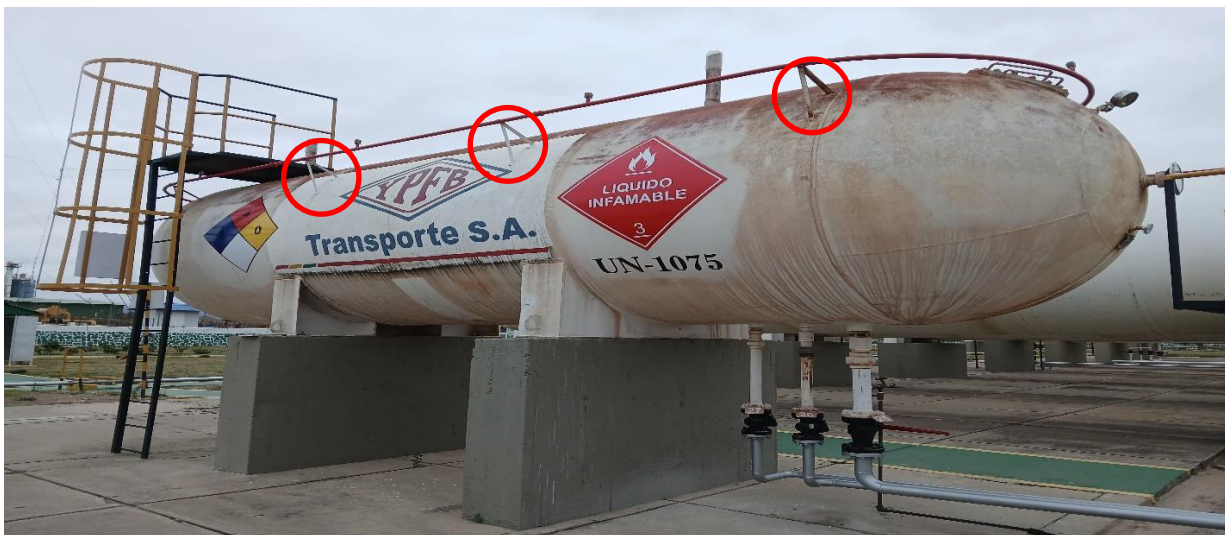
Figura 10: Aseguramiento actual de soportes del SCI y escalera en el tanque V-09
