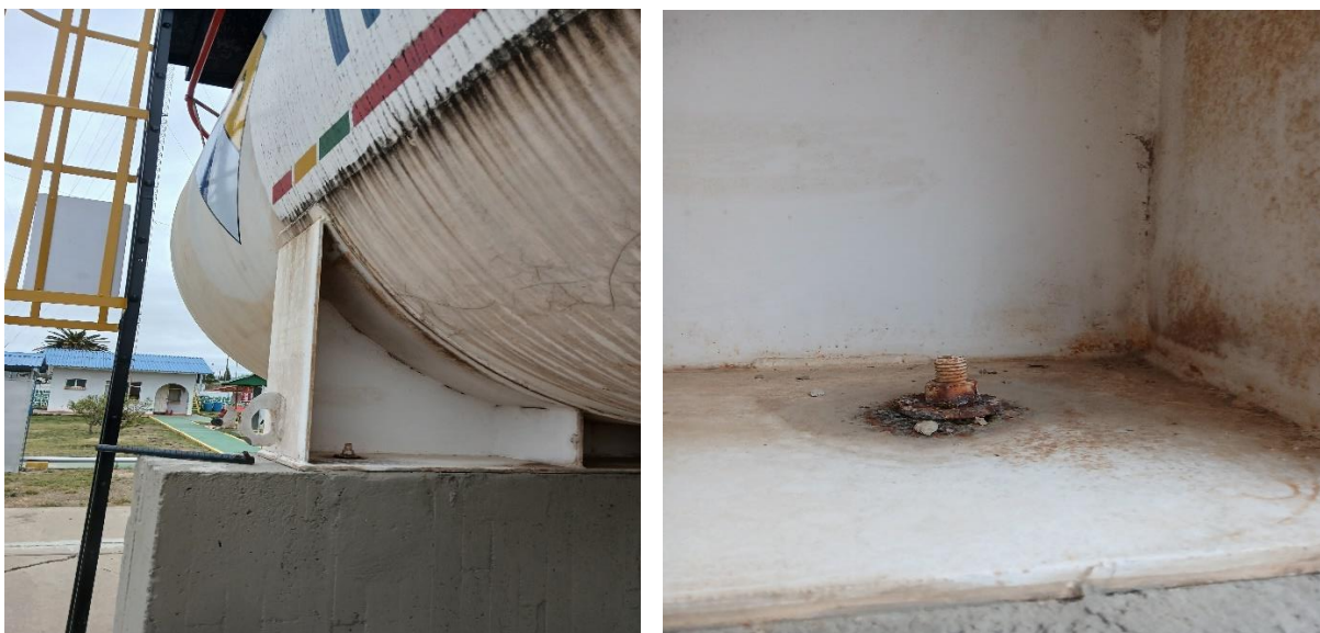
Figura 11: Pernos de aseguramiento en soportes de concreto de tanque V-09
