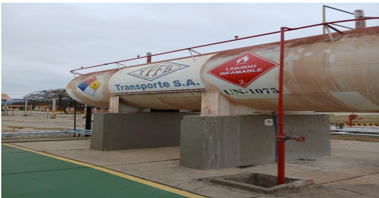
Figura 12. Leyendas y el rombo NFPA y UN 1075 que se deberán pintar en el tanque, además de la capacidad de volumen y el número identificativo de tanque en ambos laterales.
