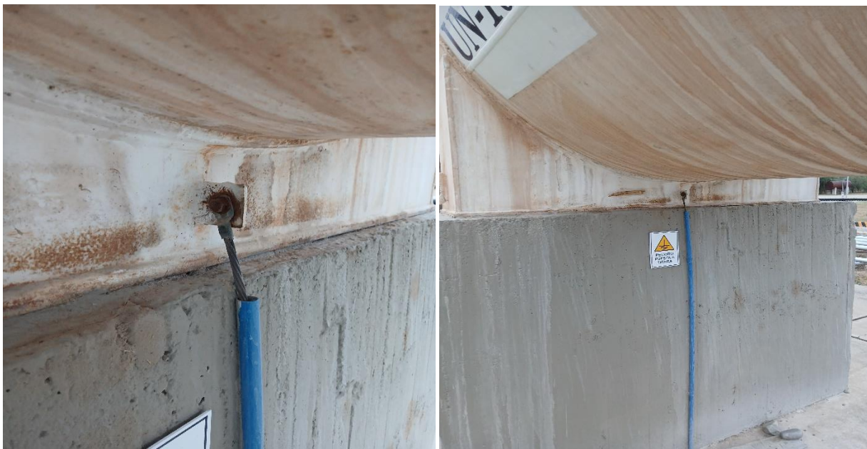
Figura 9 oreja de aterramiento actual en el tanque V-09
